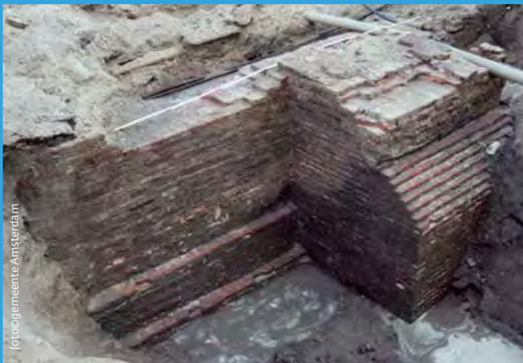
De kademuur was aan de binnenkant voorzien van zware steunberen en een dikke laag klei.
