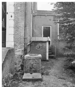
Nog tot ruim in de 20 e eeuw werd regenwater opgevangen voor huishoudelijk gebruik. Vooraan op de foto is de regenbak met houten deksel te zien
