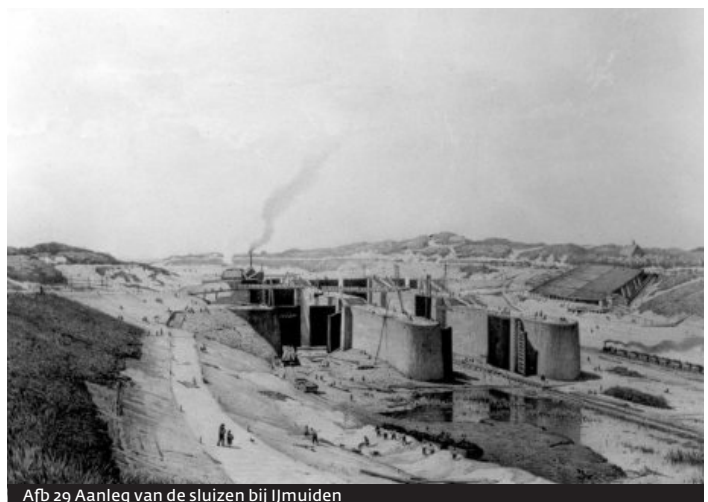
Afb 29 Aanleg van de sluisen bij IJmuiden
