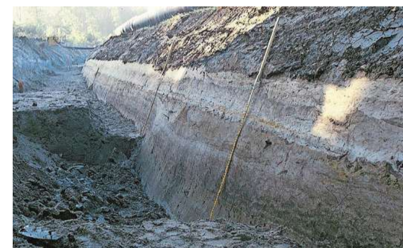
Het sluitende bewijs van de V-vormige gracht die rond het fort heeft gelegen.
