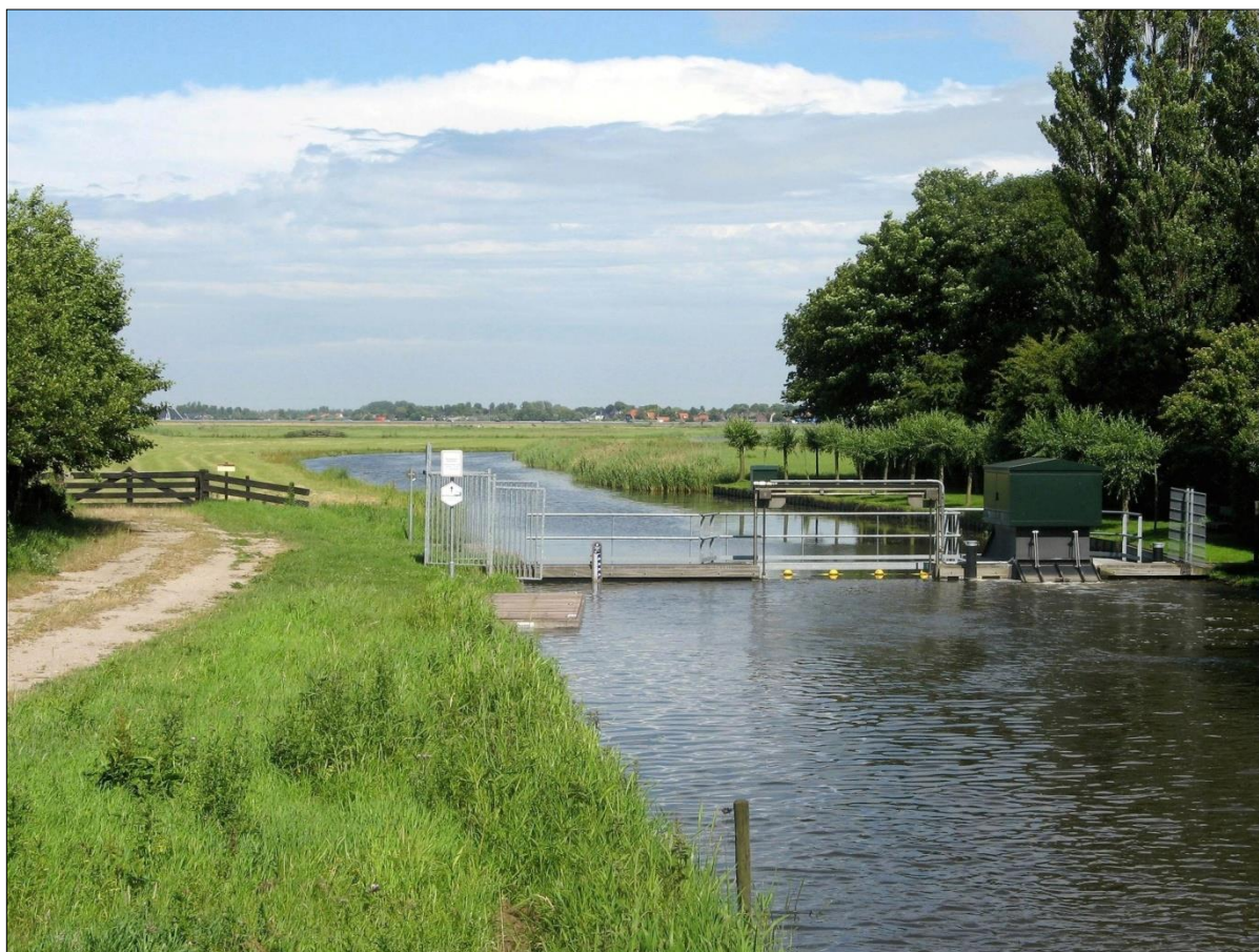
Stuw en gemaal bij de Hoge Brug.
