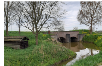
Liniedijk Wijkermeer met damsluis.
