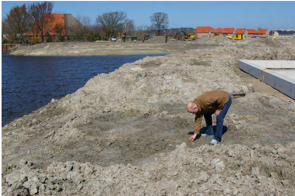
Afb. 8. 5 Het Plangebied Waldijk na het graven van de eerste waterpartijen. Op de achtergrond links zien we een van de boerderijen aan het einde van Assum, dat zowel de naam is van de oudste buurtschap als van de straat. Rechts zien we de rode daken van de nieuwbouwwijk.
