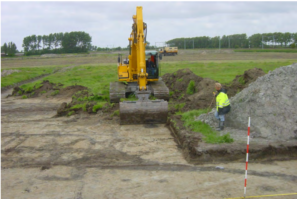
Jeroen Vaars bij de aanleg van werkput 25 (richting het noordoosten).
