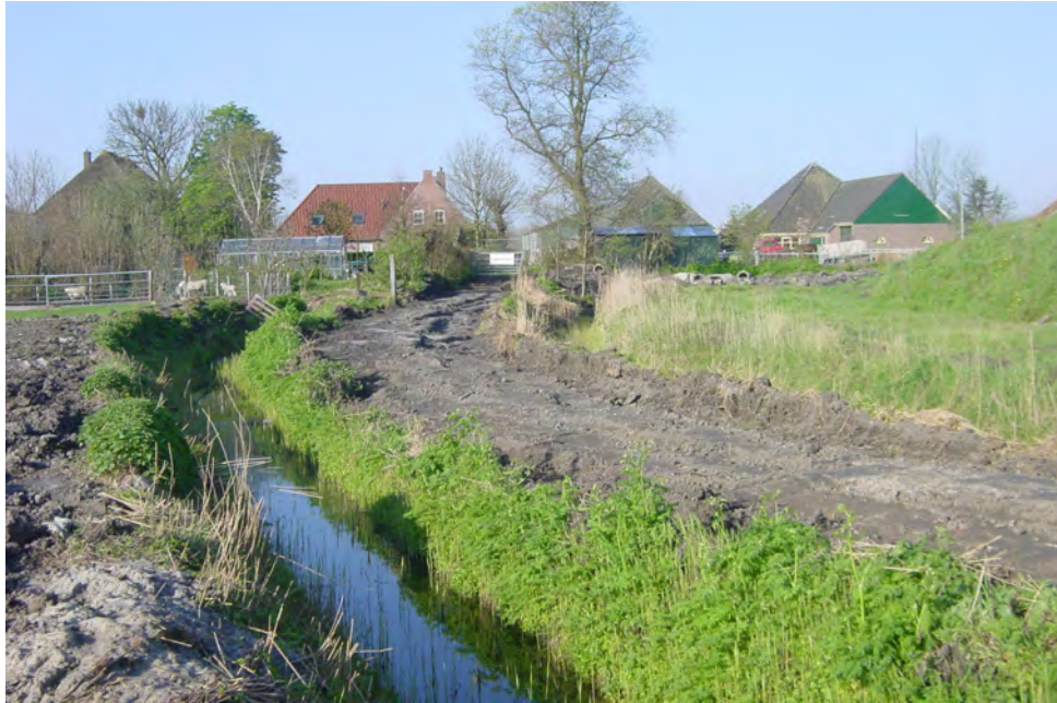
Afb.3.6 Foto: De Waldijk richting Assum. Wegens een asbestsanering is hier de bovenlaag van de dijk verwijderd.
