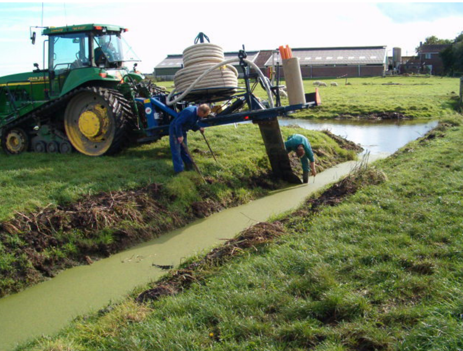
Aanleg van het drainagesysteem in Zeevang (foto: Idse Hoving (WUR))
